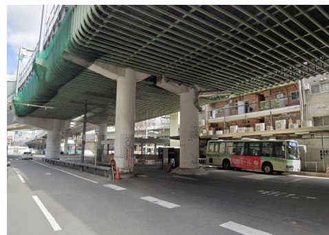
阪神高速道路1号環状線 橋脚
