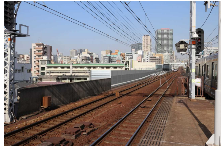
・高欄の嵩上げ (1~1.5m嵩上げ)
