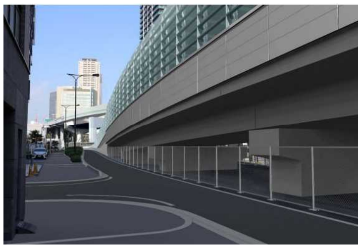
・シェルター設置
