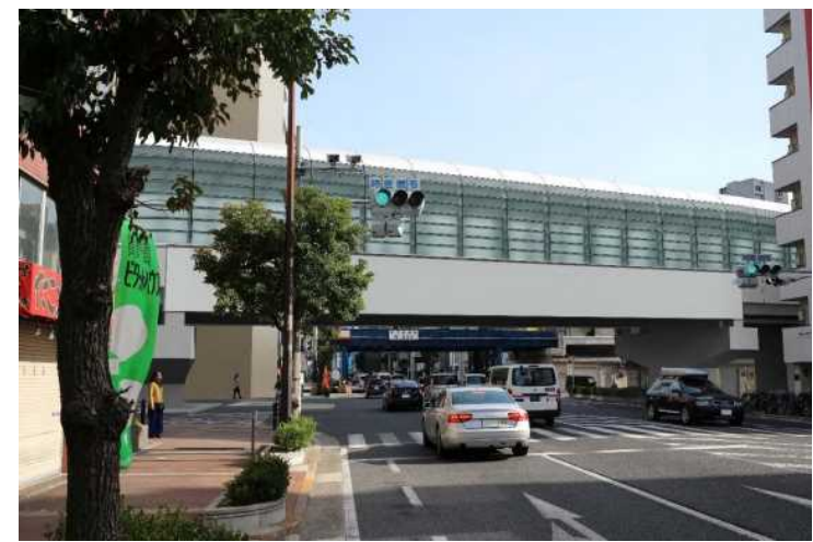
・シェルター設置
