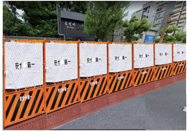
ネットフェンス
